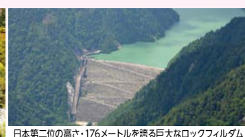
日本第二位の高さ・176メートルを誇る巨大なロックフィルダム
